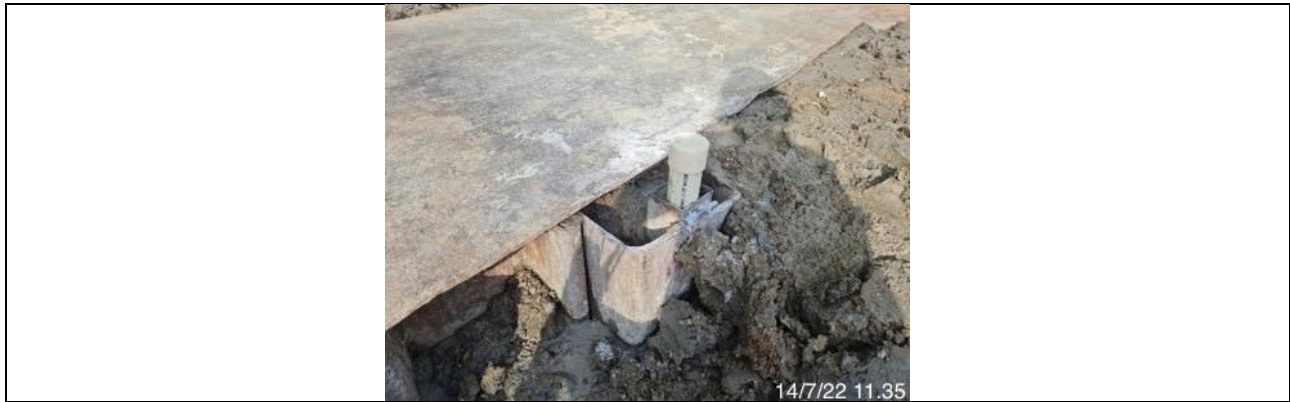
รูปที่ 2-20 การติดตั้งเครื่องมือวัดการเคลื่อนตัวของดิน (Inclinometer)
