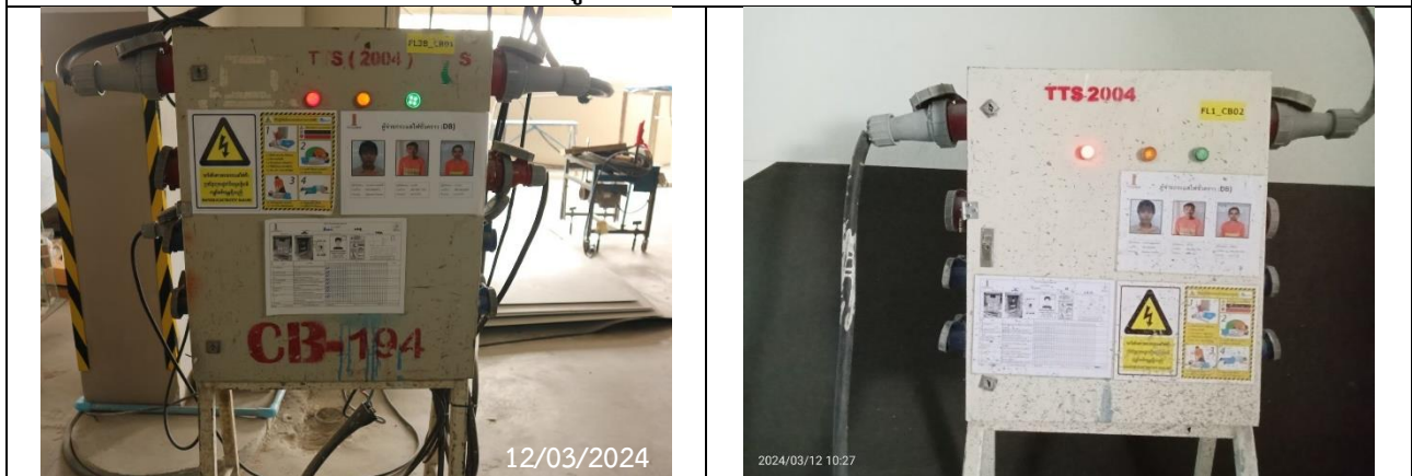
รูปที่ 2-22 ตู้ควบคุมไฟฟ้า และการตรวจสอบตู้ควบคุมไฟฟ้า
